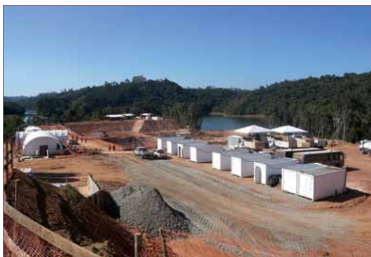
Canteiro de obras para transposição, em Juquitiba. © Ivy WIENS/ISA
